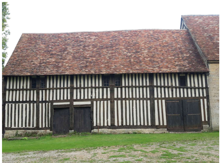
Édifice à usage de commun et d'habitation (2024)
