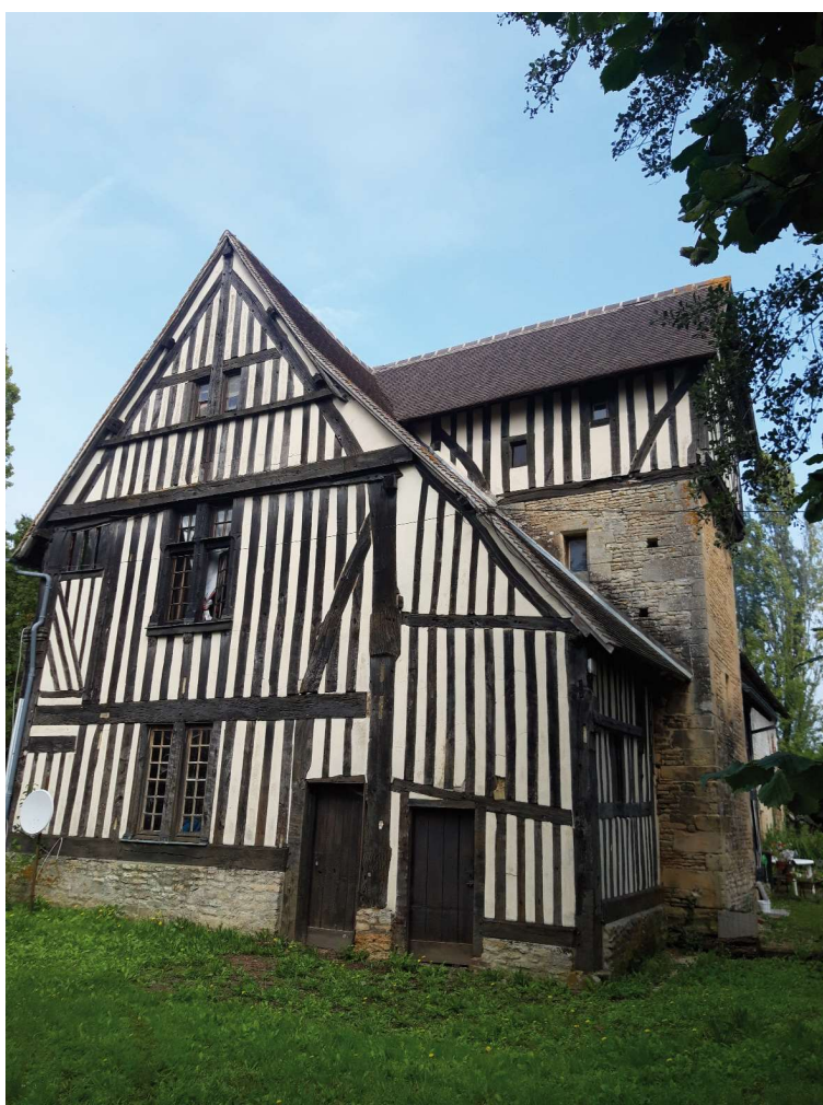
Pignon sud du logis à pans de bois et tourelle d'escalier (2024)
